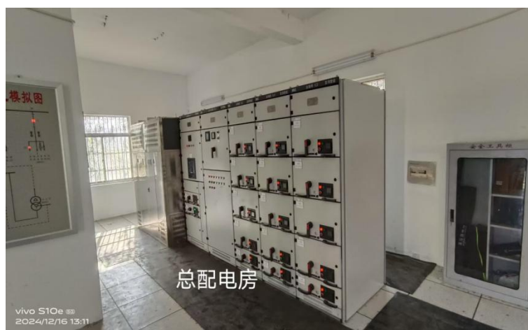
图 7-5-2 电路整体扩容项目（总配电房）
